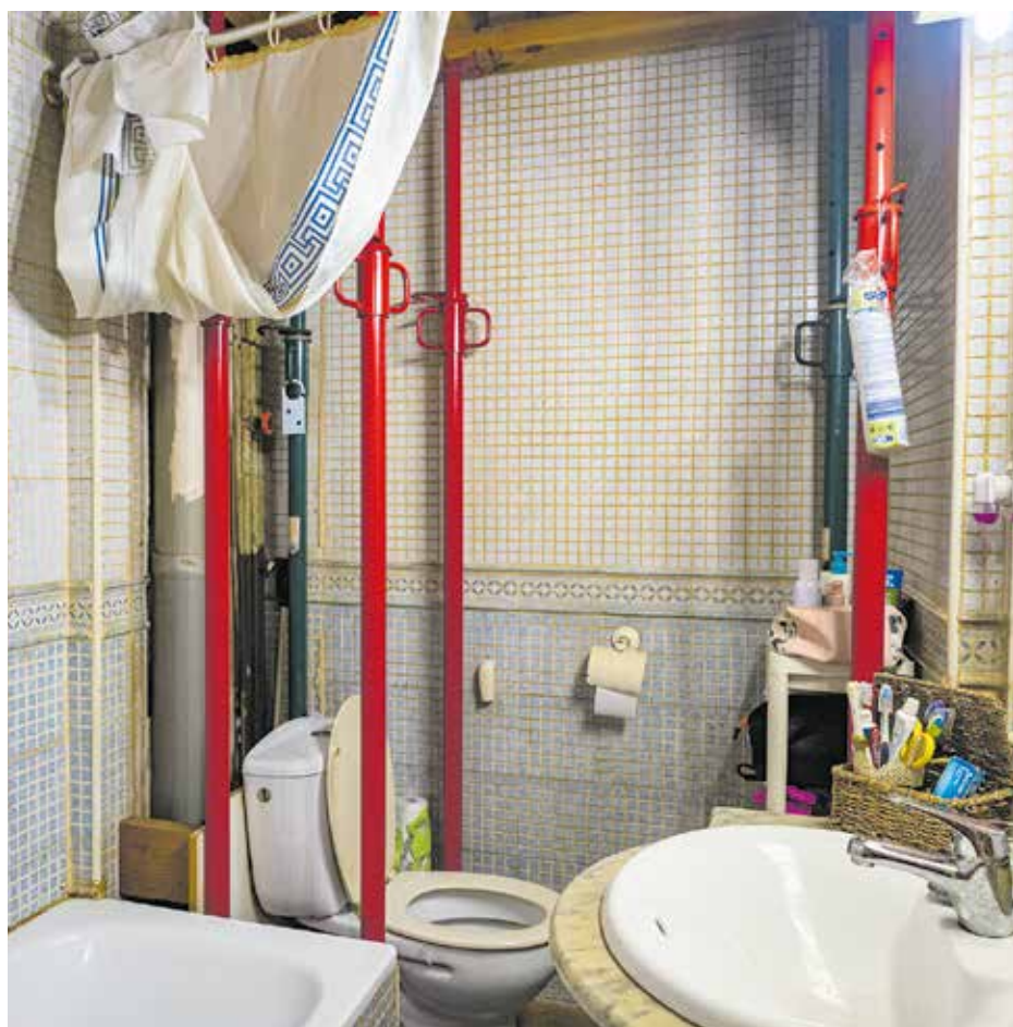
Un bany entre puntals. Interior d'un lavabo en un pis apuntalat del carrer d'Alfons el Magnànim, al barri del Besòs. Els tècnics van aconsellar els seus habitants que, quan es dutxessin, ho fessin "de pressa". L'incompliment dels plans per rehabilitar habitatges amb problemes estructurals és una de les crítiques al Pla de Barris. D.C.
