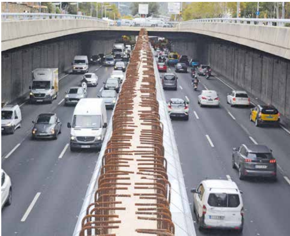
Vista de les obres de la Ronda a la zona de l'avinguda de Vallcarca. RRENOMFOTO
