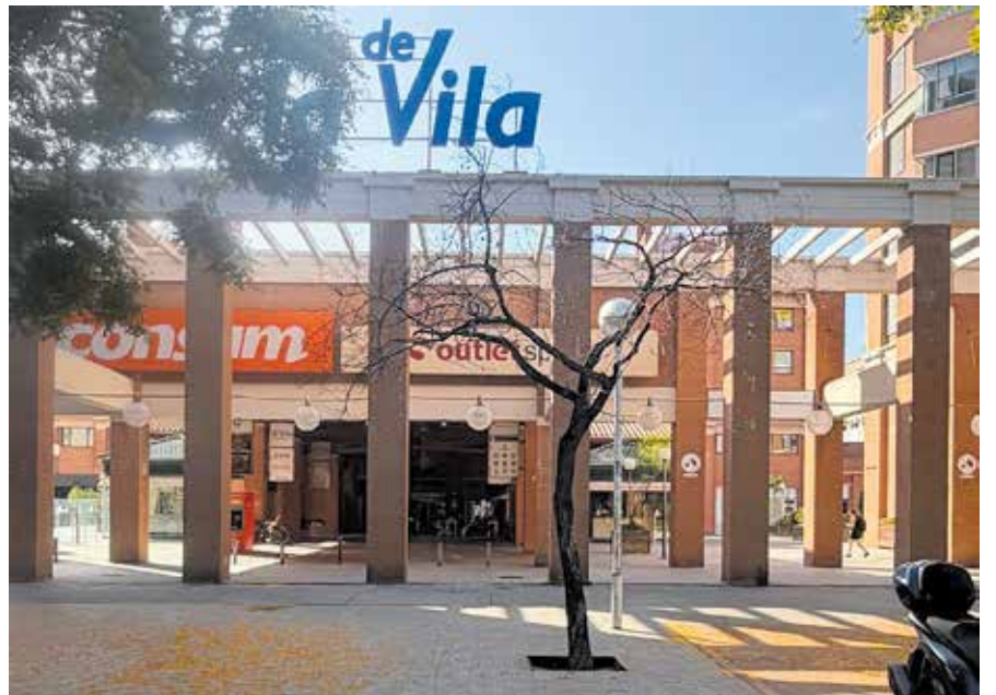
El centre comercial ha patit una progressiva degradació. AV VILA OLÍMPICA
